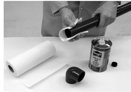
Reinigen von Rohr und Muffe
