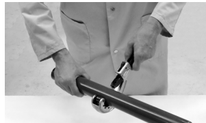
Zuschneiden der Rohre
