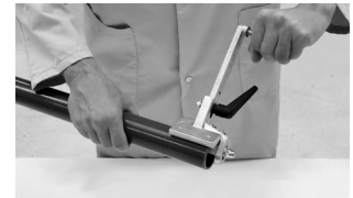
Anschrägen der Rohre
